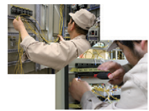
配線(線出し・結線)
